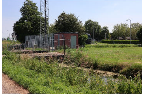
Zendmast in noordelijk deel plangebied.
