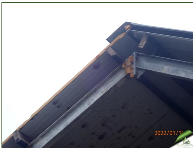
Figuur 7. Detail golfplaat constructie met isolatie
