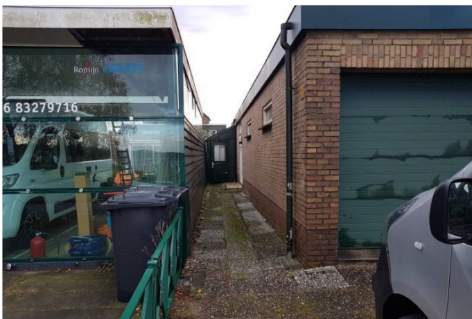
Foto 3: pad noordzijde locatie (vanaf westzijde)
