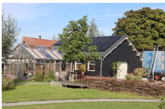
De schuur die nu gedeeltelijk binnen de bestemming 'Bedrijf' staat.
