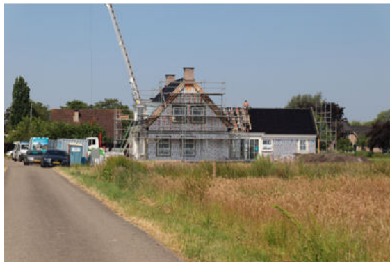
Woning in aanbouw aan Elzenbroek tussen 1 en 3.
