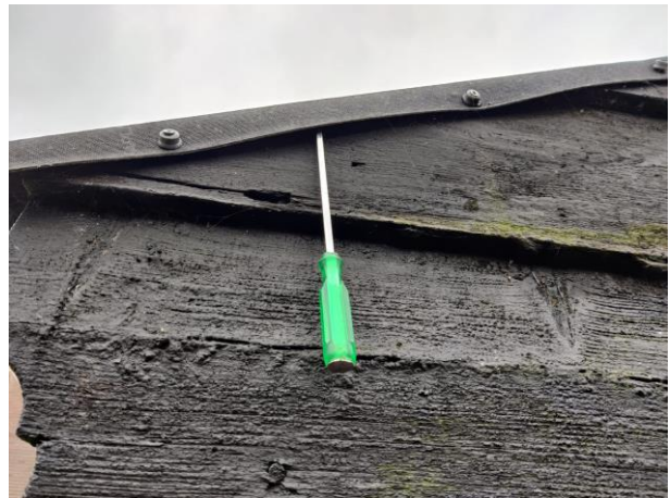
Figuur 10 Ruimte onder tussen de dakplaten en de schuur waar een schroevendraaier tussen geklemd kan worden
