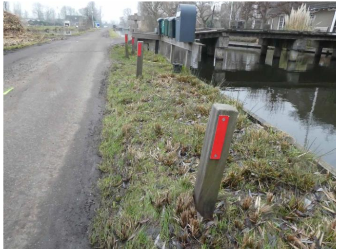
Figuur 5: Paaltjes die de berm beschermen, met goed resultaat
