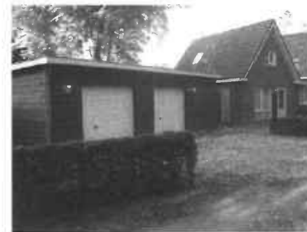
Niet toegestaan. (Materialisatie niet in stijl met de architectuur.)
