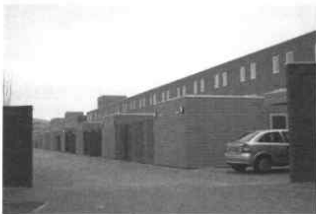
Niet toegestaan. (Niet gelijkende bouwmaterialen als het hoofdvolume.)
