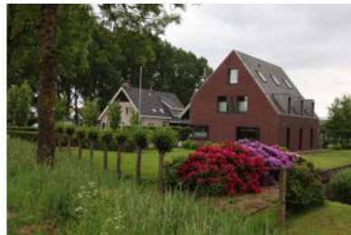
Woningen in lint van Dammekant.
