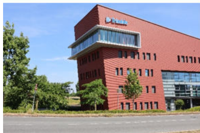
Kantoorgebouw aan de Sloep 1.
