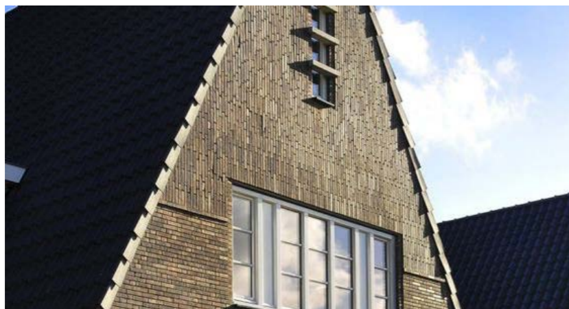
Details in metselwerk onder nok, en accent hoek
