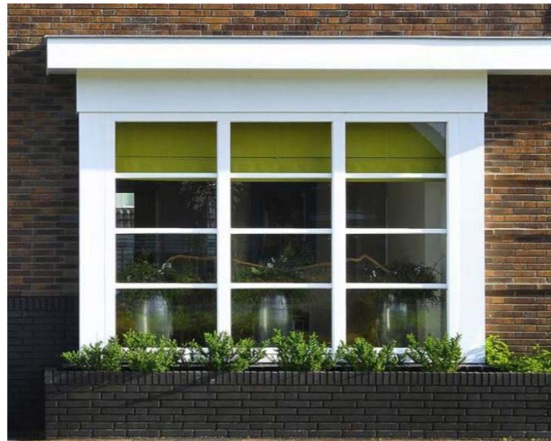
De combinatie van een erker met mee-ontworpen plantenbak aan de gevel is typisch voor de overgangsstijl
