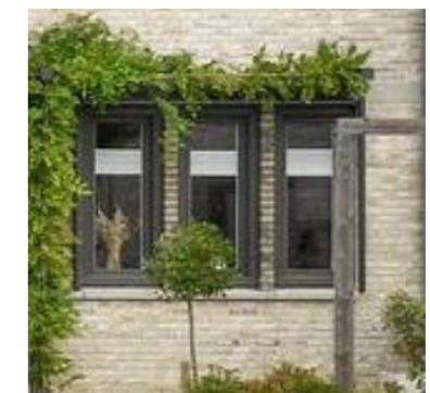
Gevelgroen en verbonden ramen
