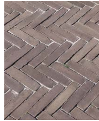
De hof wordt uitgevoerd in gebakken klinkers
