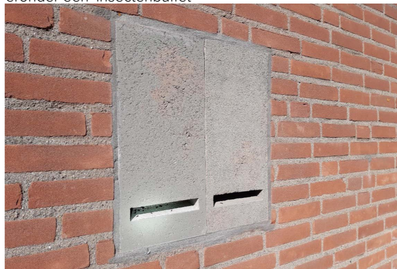
Voorbeeld van een huismuskast en een vleermuiskast in een gevel (Unitura)
